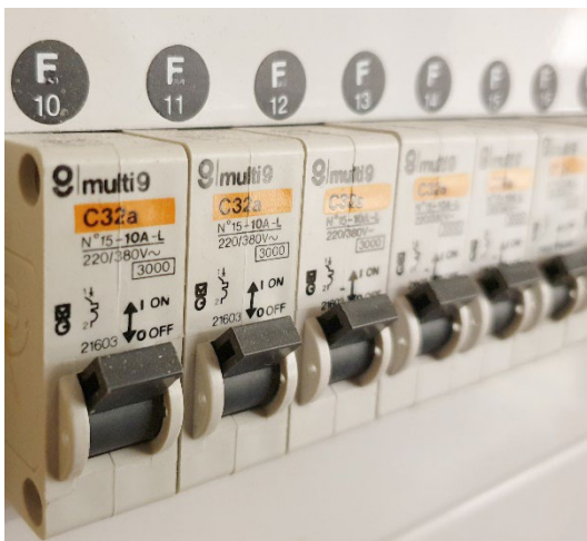
Äldre dvärgbrytare med karaktäristik L. Vad det innebär går vi igenom på utbildningen.
